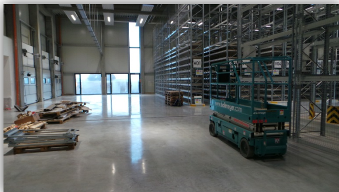
Nachher: Gereinigter Hartstoffboden mit C 2 WASH + C 2 HARD + 2x C 2 SEAL
