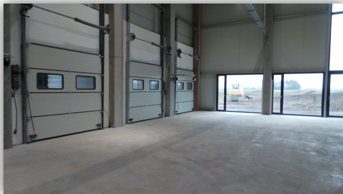
Vorher: Geglätteter Hartstoffboden, ca. 6 Wochen alt, deutliche Verschmutzung durch Montagearbeiten
