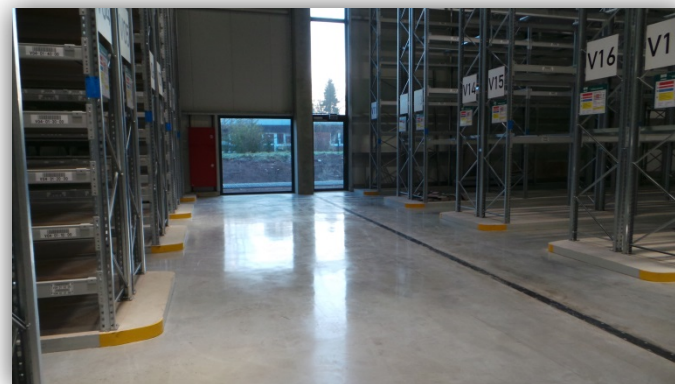
Endergebnis: Gereinigter Hartstoffboden mit C 2 WASH + C 2 HARD + 2x C 2 SEAL
